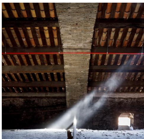
Cathédrale Sainte-Réparate de Nice, comble de la nef, détail d'une arche vue depuis le nord © Clément Guillaume / Ministère de la Culture / Centre des monuments nationaux / Médiathèque du patrimoine et de la photographie
