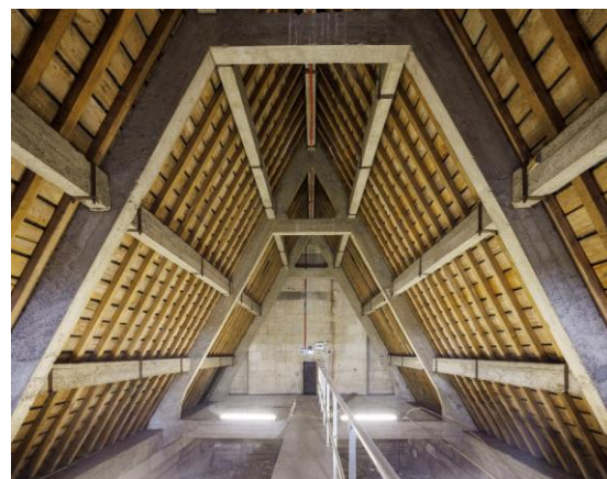
Cathédrale Notre-Dame d'Évreux, comble sud, vue vers la croisée du transept © Pascal Lemaître / Ministère de la Culture / Centre des monuments nationaux / Médiathèque du patrimoine et de la photographie
