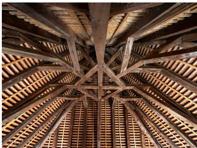
Cathédrale Saint-Étienne de Cahors, comble du beffroi, vue en contre-plongée de la charpente de la passerelle sud © Patrick Tourneboeuf / Tendance floue / Ministère de la Culture / Centre des monuments nationaux / Médiathèque du patrimoine et de la photographie
