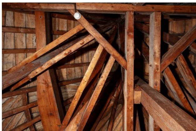
Cathédrale Saint-Pierre de Moûtiers, vue en contre-plongée du comble de l'abside, détail de la charpente © Xavier Spertini / Ministère de la Culture / Centre des monuments nationaux / Médiathèque du patrimoine et de la photographie
