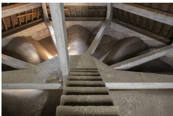
Cathédrale Saint-Dié de Saint-Dié-des-Vosges, comble de l'abside, détail de la partie basse de la charpente en béton et des extrados Monument : Cathédrale Saint-Dié (Saint-Dié-des-Vosges) © Laurent Kruszyk / Ministère de la Culture / Centre des monuments nationaux / Médiathèque du patrimoine et de la photographie
